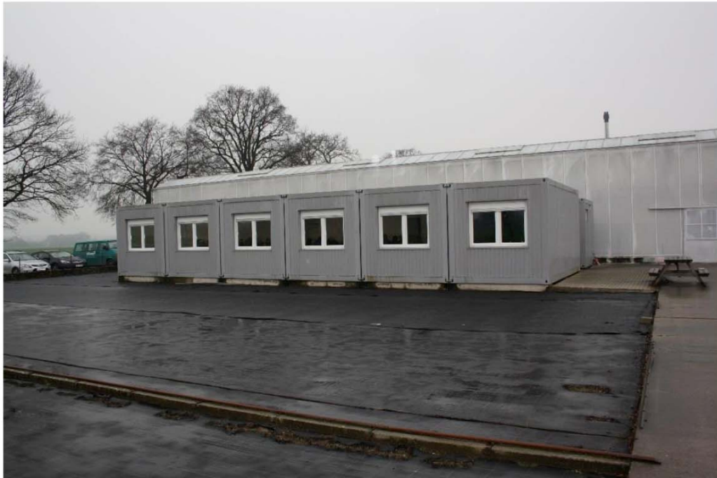
Abbildung 2.4: Aufenthaltsräume und sanitäre Anlagen in Container-Bauweise sowie davor gelegene Ansaatbeete mit schwarzer Abdeckfolie
