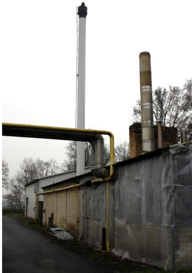
Abbildung 2.6: Gebäude mit Heizungsanlage
