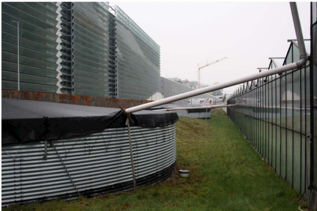
Abbildung 2.5: Wassertanks an der Nordwestgrenze
