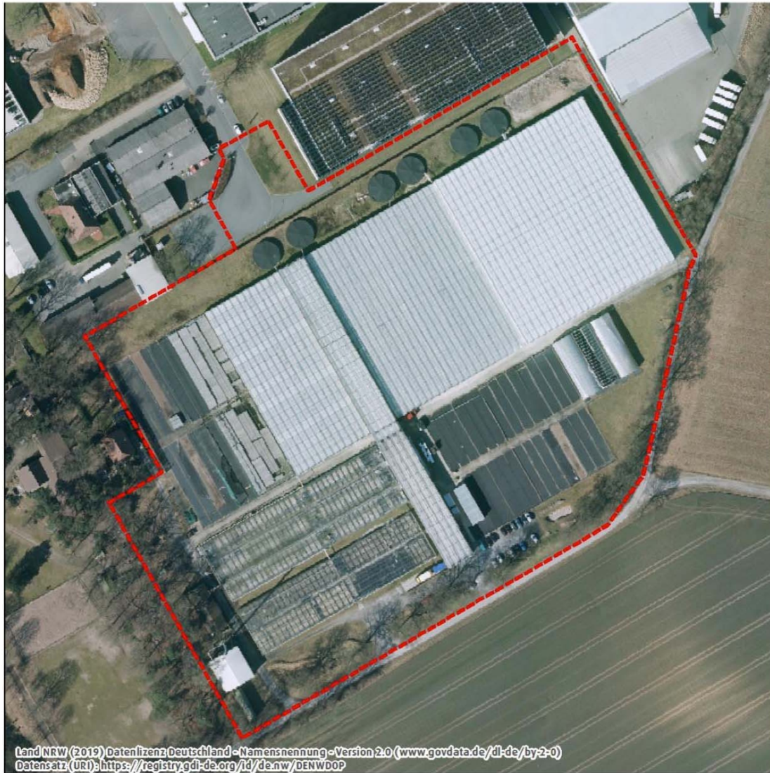
Abbildung 2.9: Luftbild des Plangebiets (innerhalb der roten Grenzlinie) und der näheren Umgebung
