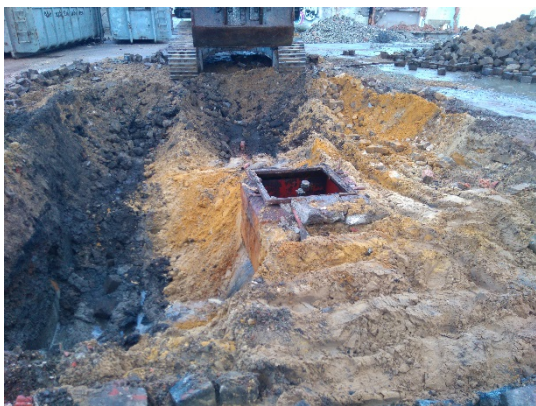
SB 4 – Erkundung der Tanks
