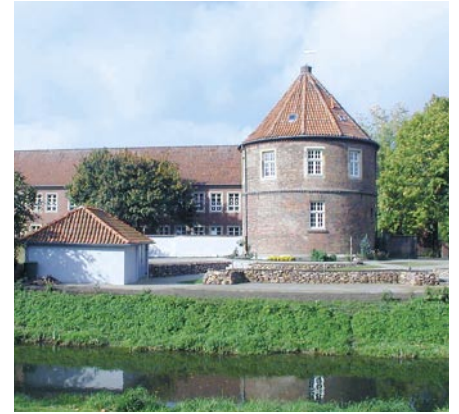
Wehr und Pulverturm im Bereich des Südwalls
