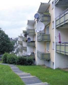
Gestalterische Störungen durch Antennen- und Lüftungsanlagen
