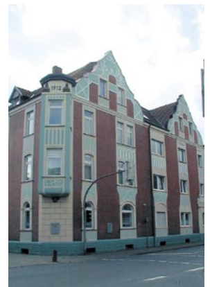
Geschlossene Bebauung im Bereich Wiesen- und Bahnhofstraße
