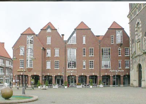
Zeitgenössische Gebäude nehmen historische Strukturelemente auf
