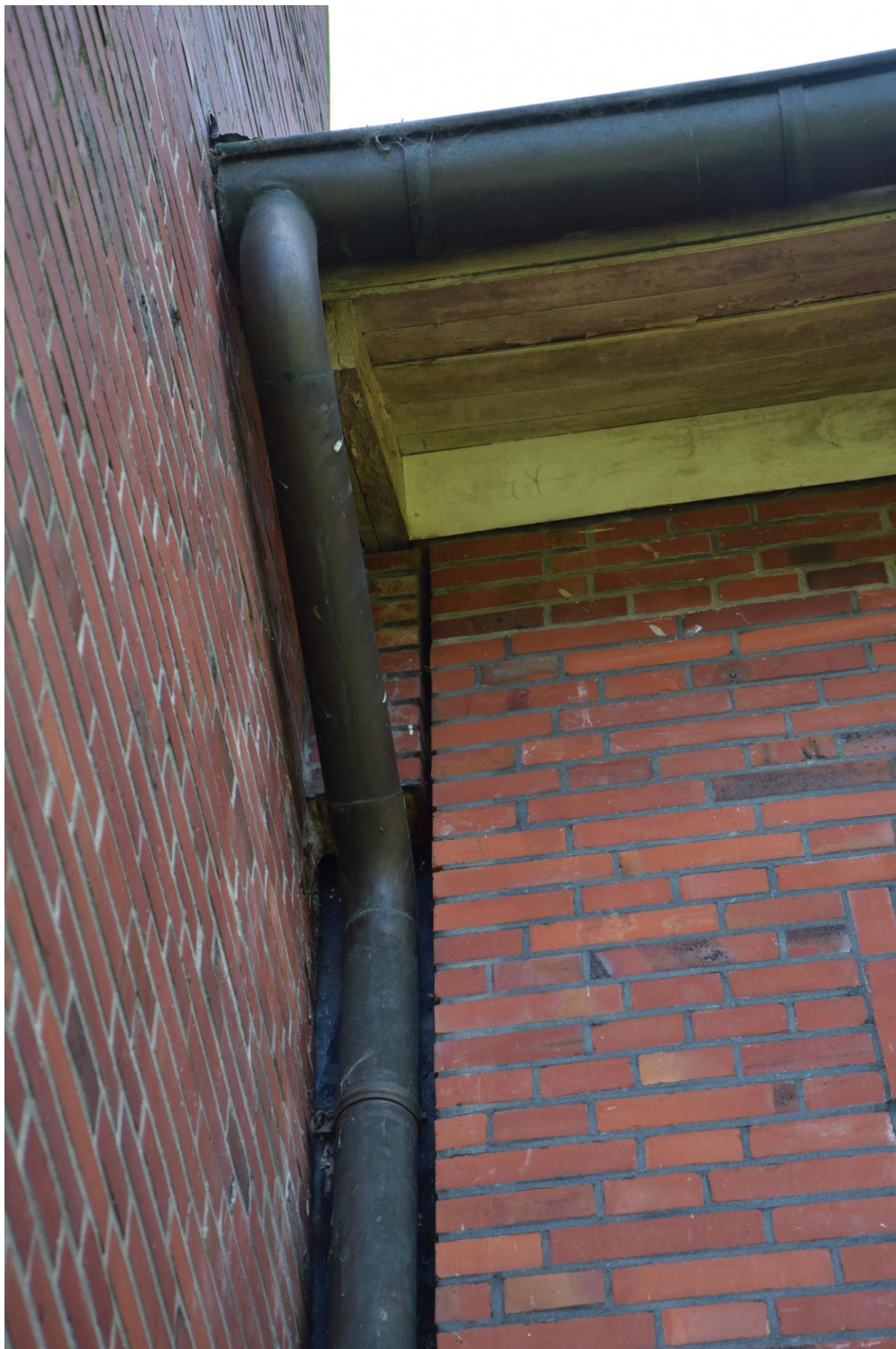
Potentiellles Spaltenquartier am Anschluss Hauptgebäude-Glockenturm
