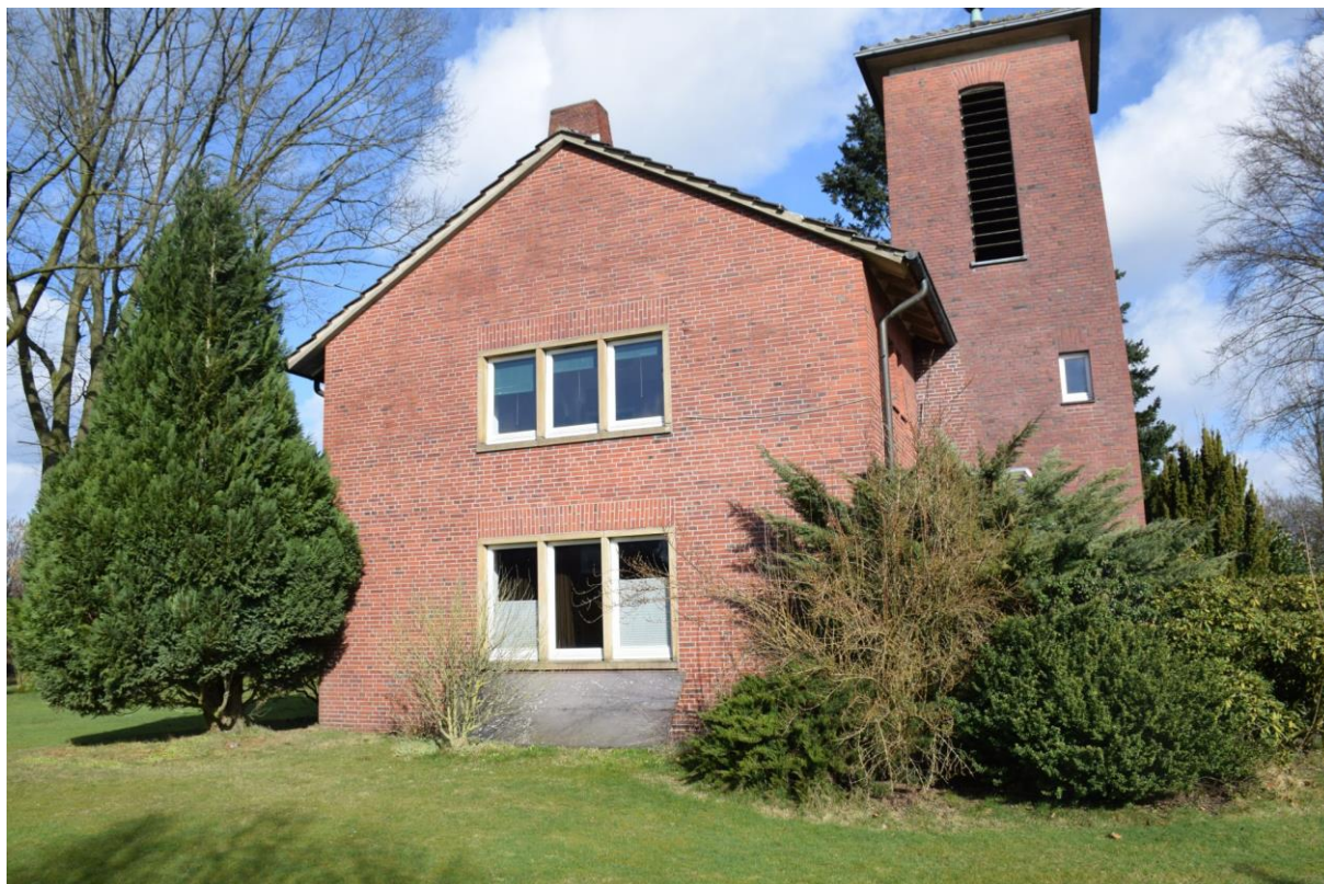
Südwestfront des Gebäudes
