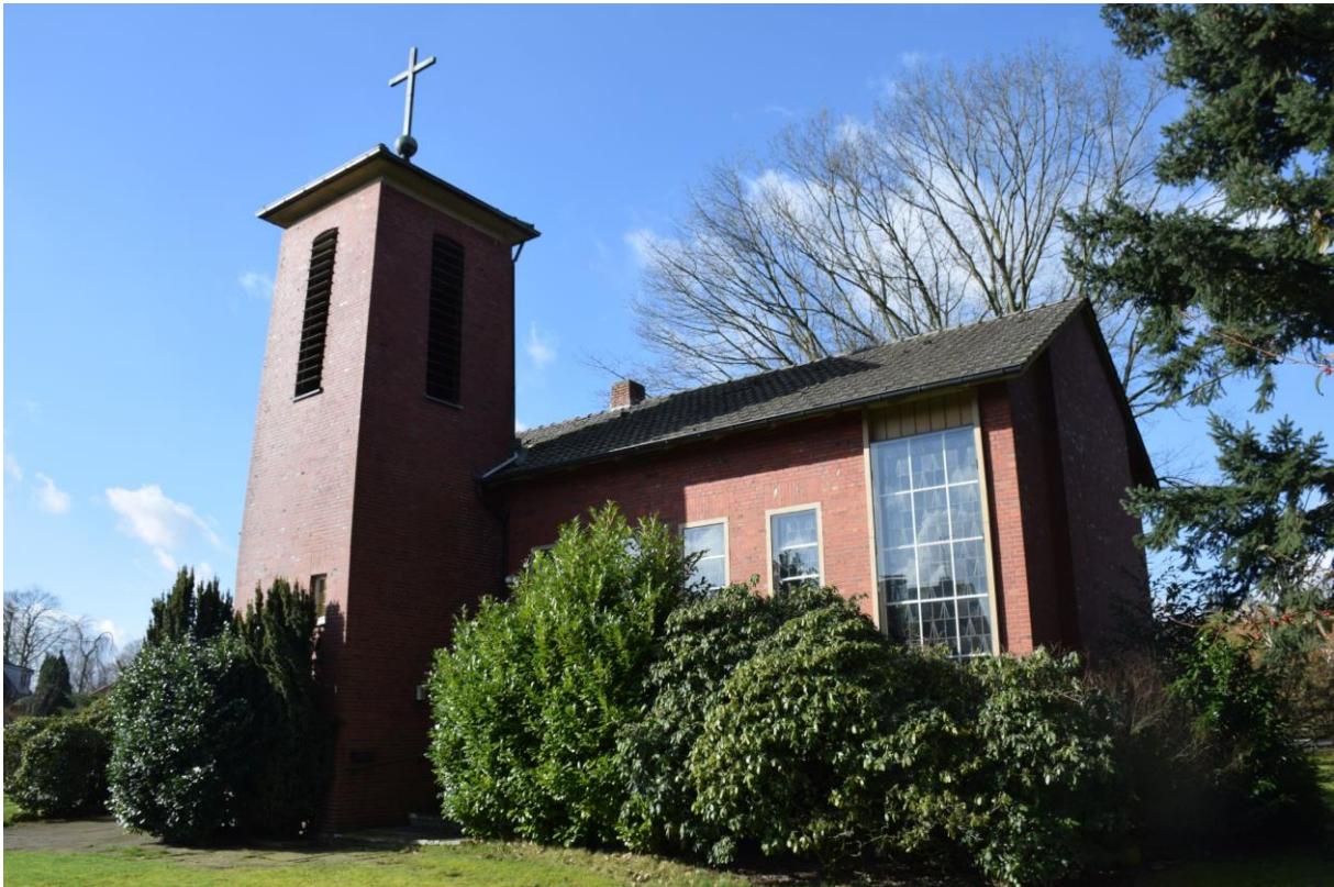
Das betroffene Gebäude (Südost-Seite)
