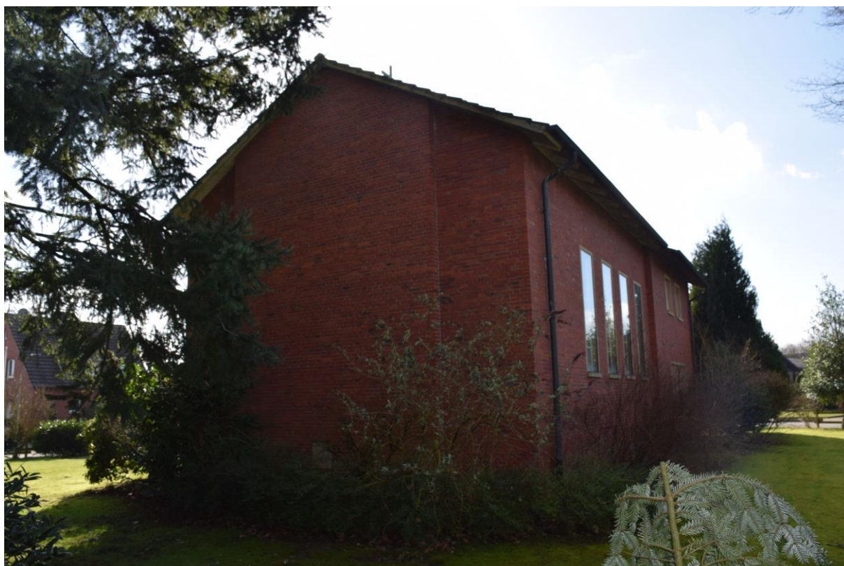
Rückwärtige (Nordöstliche) Seite des Gebäudes
