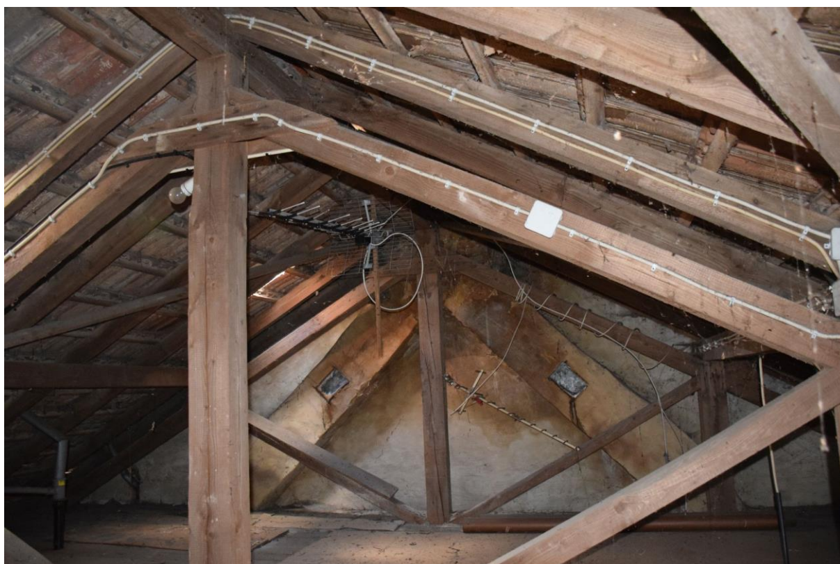
Innenansicht Dachboden Wohnteil
