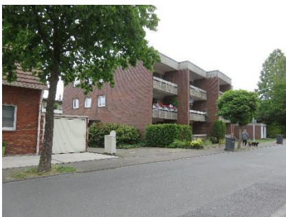
Abbildung 6: Foto Gebäude an der Mittelstraße 25/27
