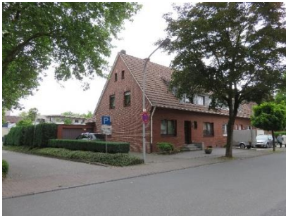
Abbildung 5: Foto Gebäude an der Mittelstraße 21/23
