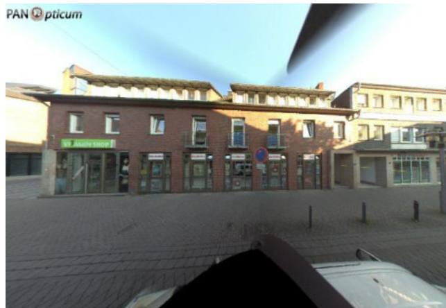
Abb. 4: Gebäude Kupferstraße 20/20a u. 18
