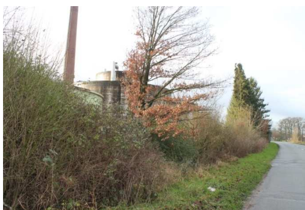
Abbildung 2: Ansicht von Straße
