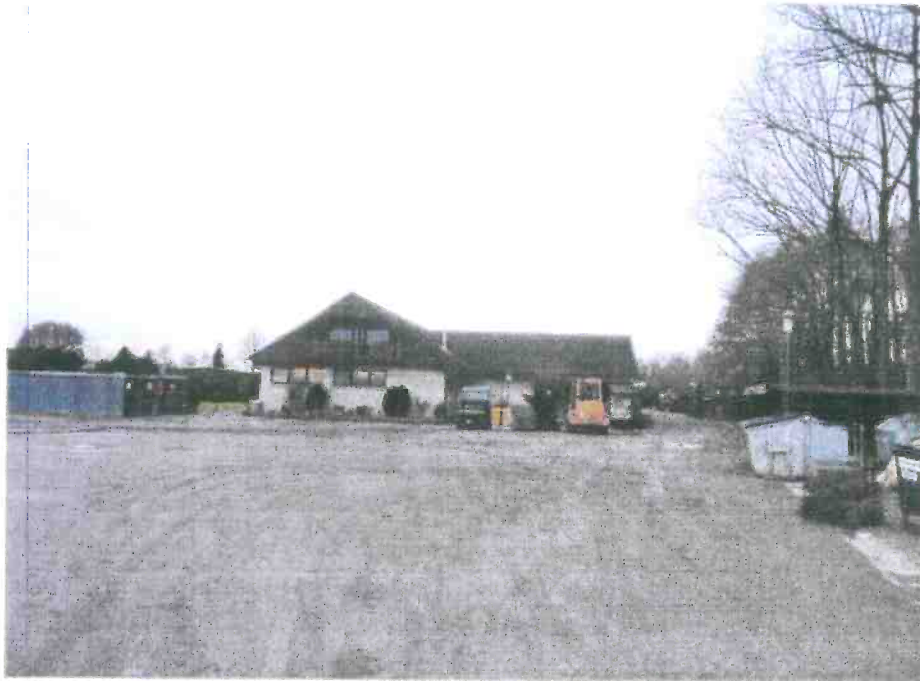
Abb. 6: zentraler Platz im Plangebiet mit Dusch- und Toilettengebäude sowie Kiosk-Anbau
