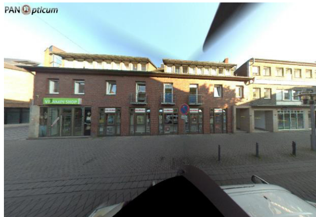
Abb. 4: Gebäude Kupferstraße 20/20a u. 18
