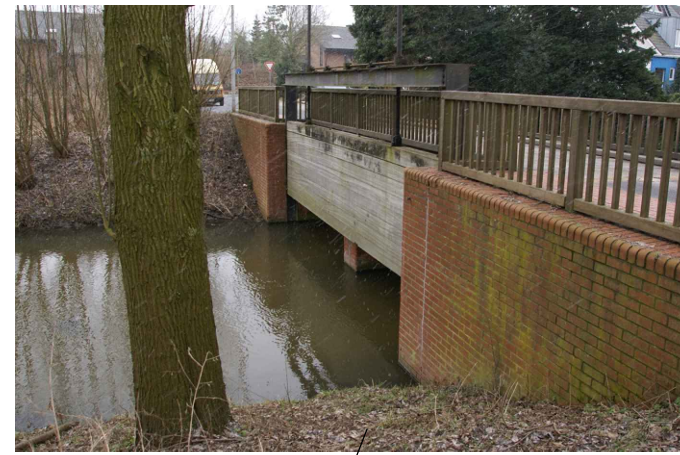
Ansicht Brücke Blomenesch Oberhalb
