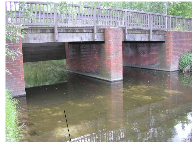
Ansicht Brücke Blomenesch Unterhalb
