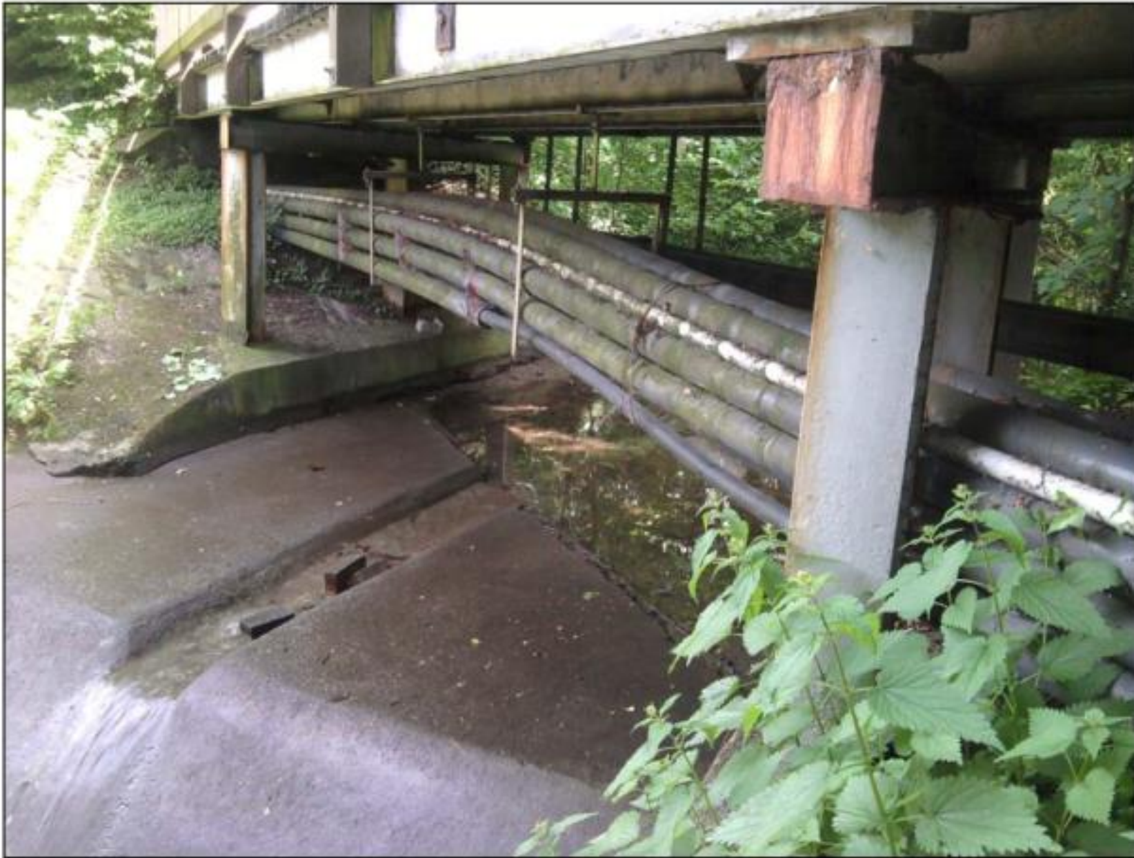
Anlage 5: Befestigte Sohle im Mündungsbereich der Fegetasche
