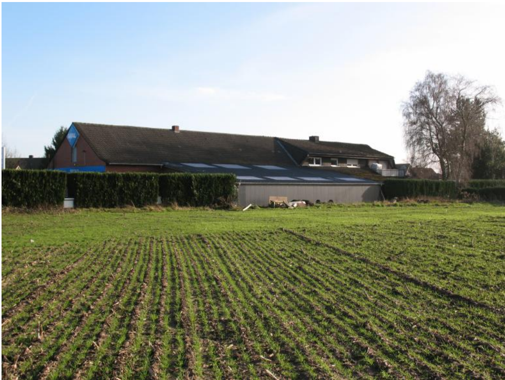
Die Tankstelle am nördlichen Ortseingang soll auf der rückwärtig gelegenen Ackerfläche erweitert werden. (Fotos 28.12.2015)
