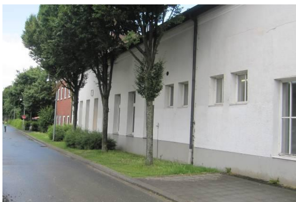
Abbildung 8: Westseite Empfangsgebäude, nördlicher Teil
