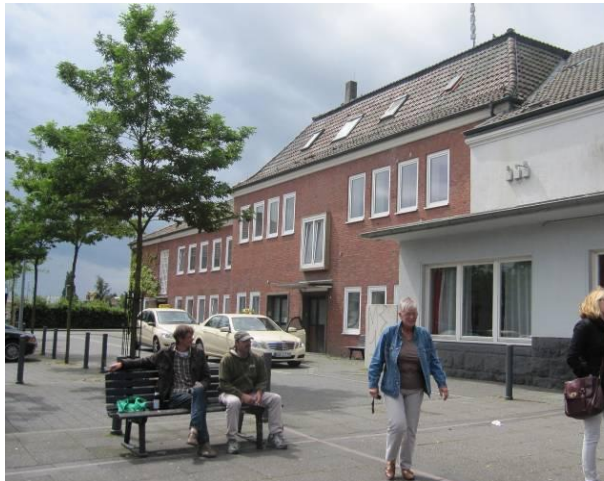
Abbildung 4: Ostseite Empfangsgebäude, südlicher Teil
