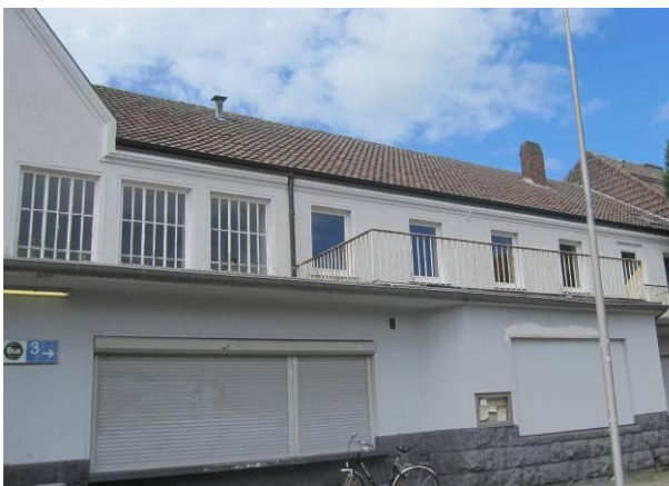
Abbildung 5: Ostseite Empfangsgebäude, nördlicher Teil
