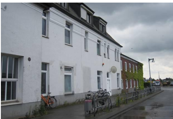
Abbildung 7: Westseite Empfangsgebäude, südlicher Teil
