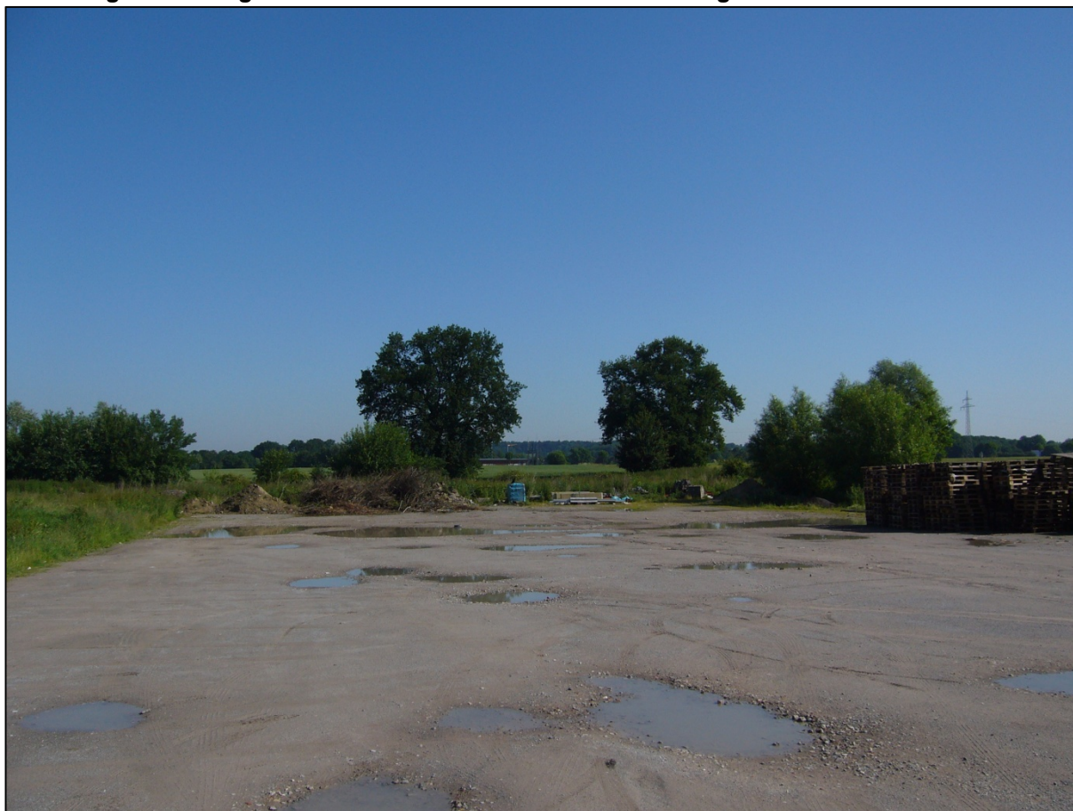
Abbildung 7: Wassergebundene Oberfläche Betriebserweiterungsbereich 4
