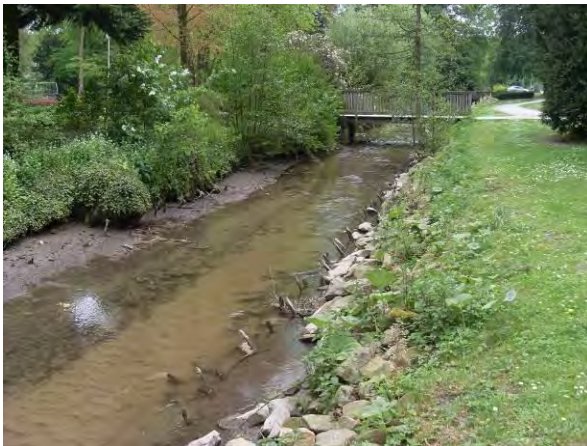
Abbildung 44: Strukturelle Ansätze am Ufer links, Sandrippel in der Sohle, Wasserbausteine rechts
