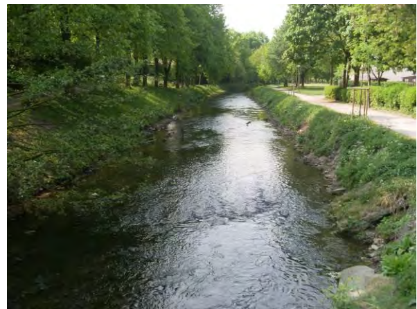
Abbildung 19: Die Strömungsdiversität wird hauptsächlich von Bauschutt initiiert
