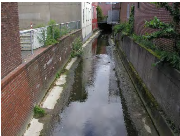
Abbildung 24: Betonierte Sohle und gemauerte Ufer in der Innenstadt
