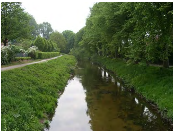
Abbildung 18: Monotones Trapezprofil mit Ruderalsaum an den Ufern (gegen die Fließrichtung)
