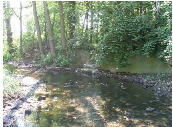
Abbildung 23: Gehölzbestandene Fläche mit Uferverbau rechts
