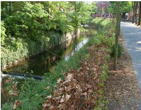
Abbildung 26: Ausgebauter Stadtgraben: Die Umflut, unterer Teil (gegen die Fließrichtung)
