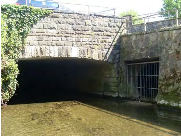
Abbildung 20: Ende des Durchlasses Kupferstraße mit sandiger Sohle
