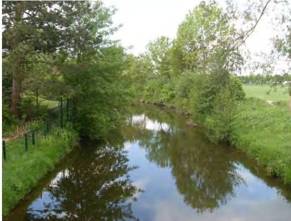
Abbildung 34: Regelprofil, rechtsseitig Damm und im Hintergrund das HRB, links Privatgarten mit Nadelgehölz
