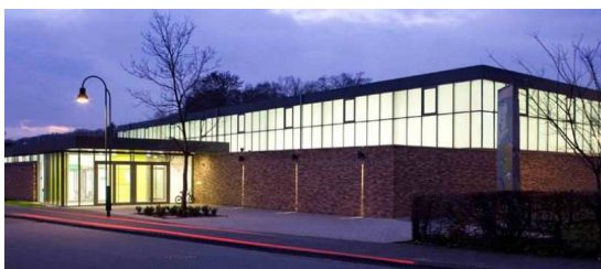
Sporthalle in Herzebrock-Clarholz mit Lichtstreuender Isolierverglasung
