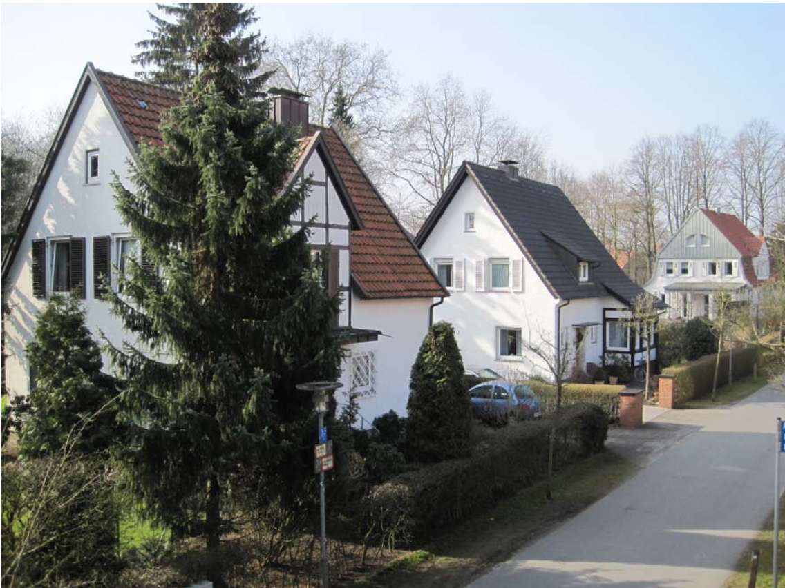
Blick in die Straße an den Kämpen (Abrissvorhaben: vorderes Haus mit dem Fachwerkgiebel)
