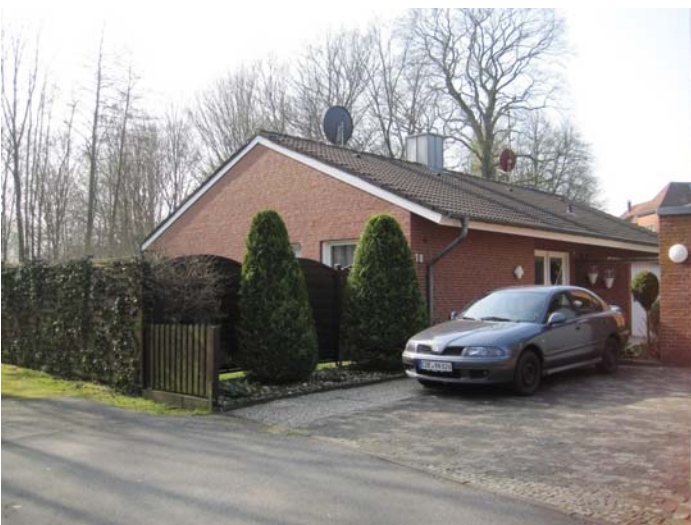
Niedrigstes Haus im Umfeld, gelegen hinter dem Abrissobjekt
