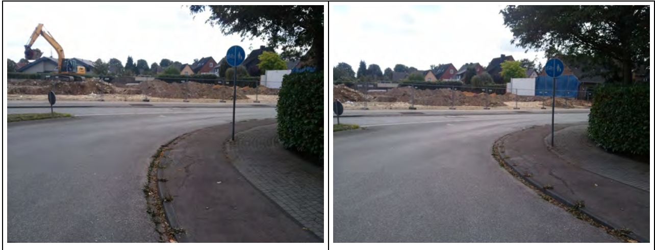
Abbildung 7: Sicht beim Rechtsabbiegen von der Daruper Straße in die Bahnhofstraße
