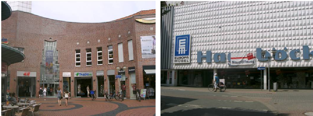
Abbildung 61: Fassadengestaltung im Innenstadtzentrum von Coesfeld
