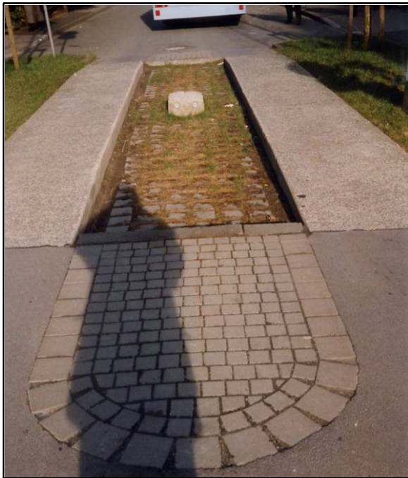
Beispiel einer baulich angelegten Busschleuse (Lemgo)
