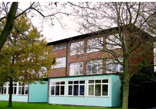
Außenansicht EG Altbau
