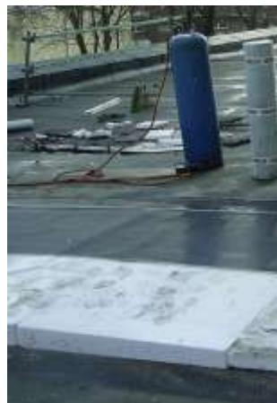
Gefälledämmung Schulzentrum
