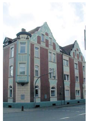
Geschlossene Bebauung im Bereich Wiesen- und Bahnhofstraße
