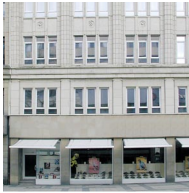
Gelungene Einbindung der Markisen in die Fasadensstruktur
