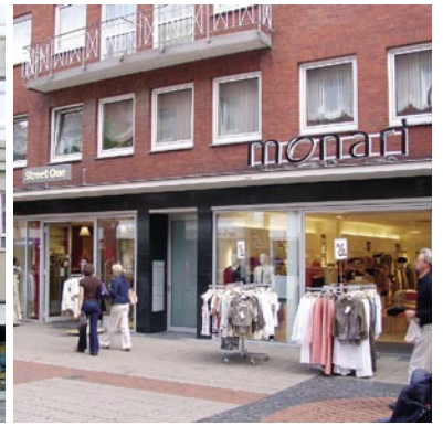
Glasvordach (oben rechts)
