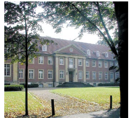
Villa im Bereich der Promenade (Mitte) Kreisverwaltung (rechts)
