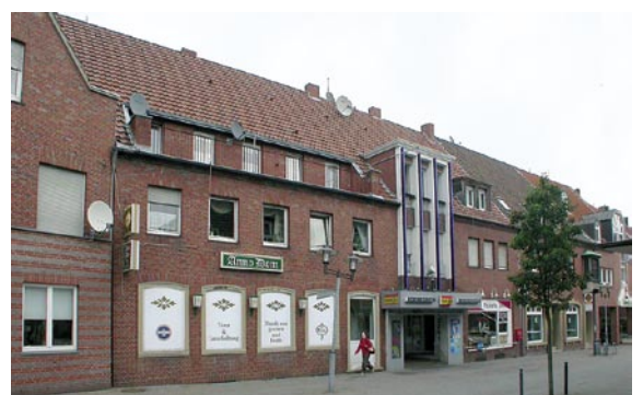
Gestalterische Störungen durch dauerhaft verklebte Fenster
