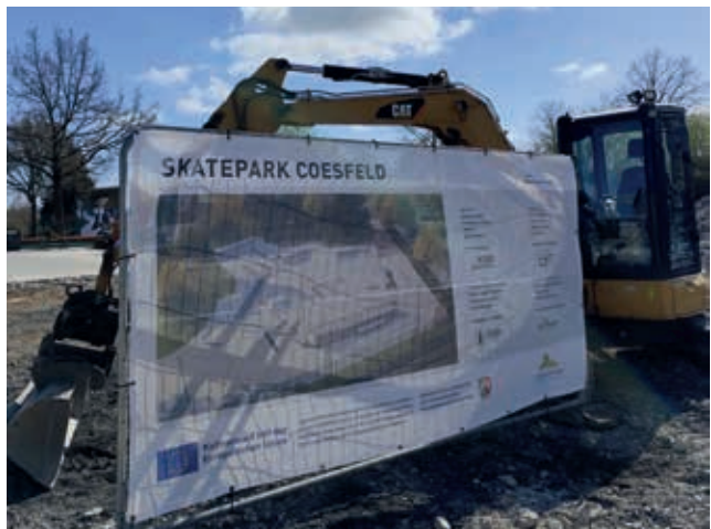
Bau der neuen Skateanlage bis September 2026
