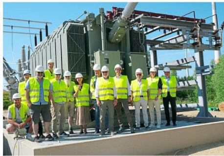
Der Aufschub der Stadtwere Coesfeld besichtigt die Baustelle am Umspannwerk.
