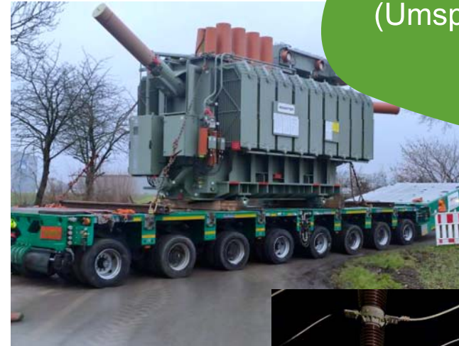
Umspannwerk Kalksbeck: Anlieferung 110 KV Trafo und Nachaktion zur Umschaltung der KV Sammelschiene
