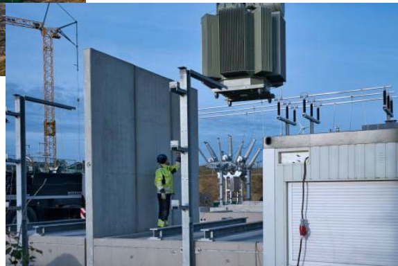
Umspannwerk Kalksbeck: Anlieferung 110 KV Trafo und Nachaktion zur Umschaltung der KV Sammelschiene
