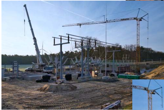
Umspannwerk Hohes Venn: Errichtung Schaltheis und Anlieferung E-Spulen
