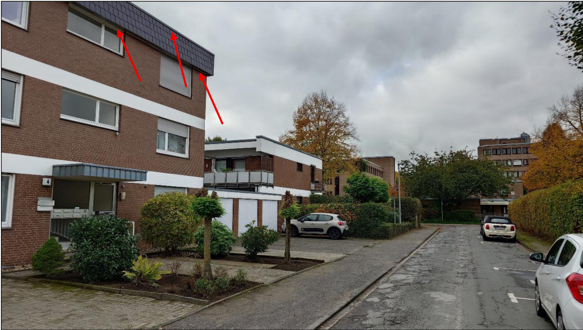
Foto 2: Blick auf einige der Gebäude innerhalb des Geltungsbereichs – Strukturen für Fledermäuse (rote Pfeile) vorhanden.
