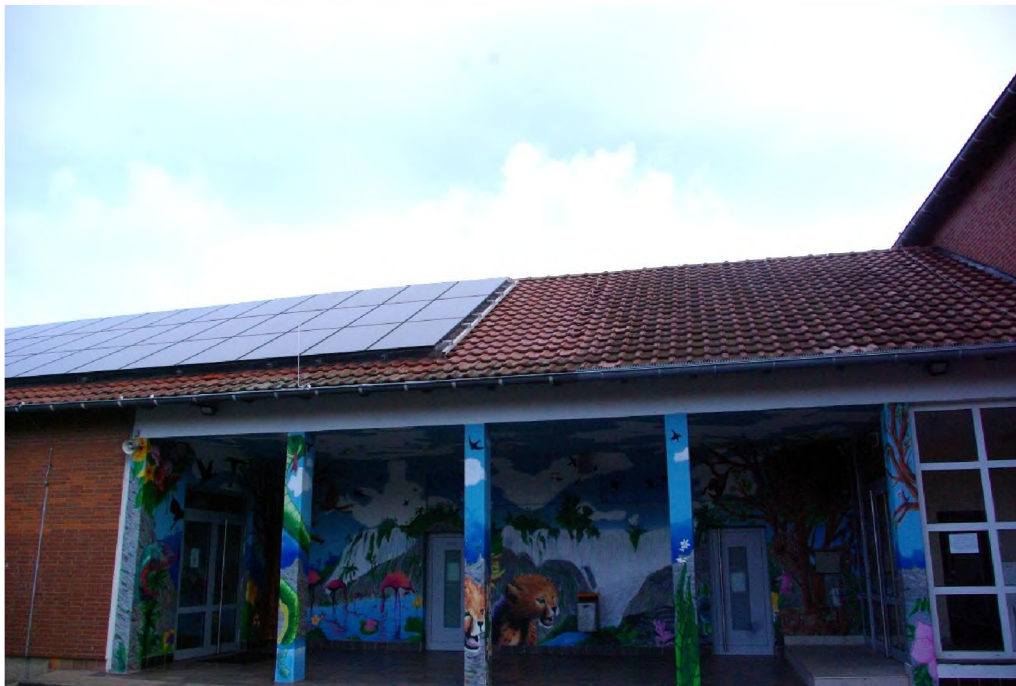
Abb. 3 offener Pausenbereich mit dahinterliegendem Toilettenbereich
