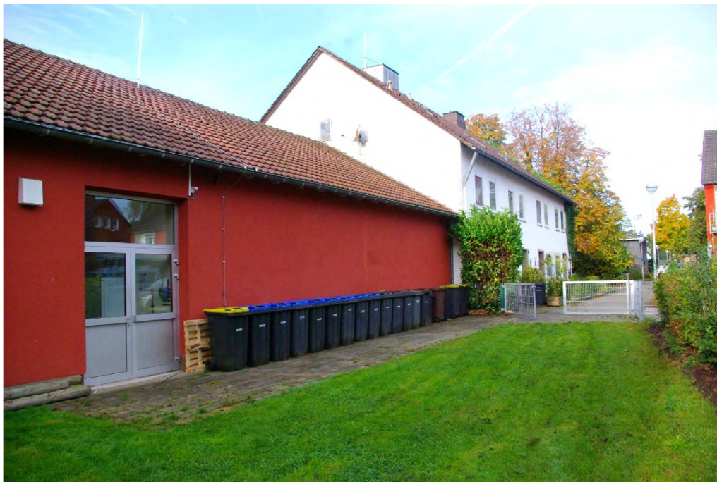
Abb. 4 Aulabereich von der Rückseite mit Wärmedämmverbundsystem
