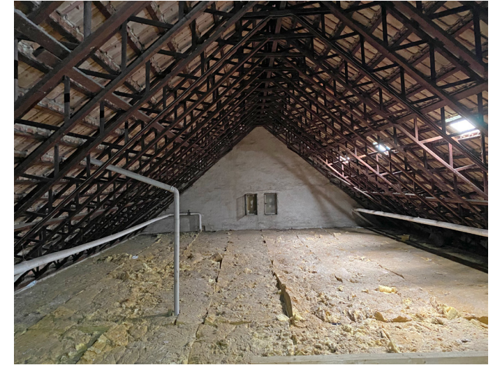
Der unausgebaute Dachboden stellt eine potenzielle Raumreserve für die Zukunft dar. Derzeit ist der Dachraum jedoch nur über einen einzigen Treppenausgang erreichbar. Da das Fußbodenniveau mehr als 7 m über dem Gelände liegt, wäre eine Nutzung mit erhöhten Anforderungen an den Brandschutz der tragenden Bauteile des Gebäudes verbunden.
