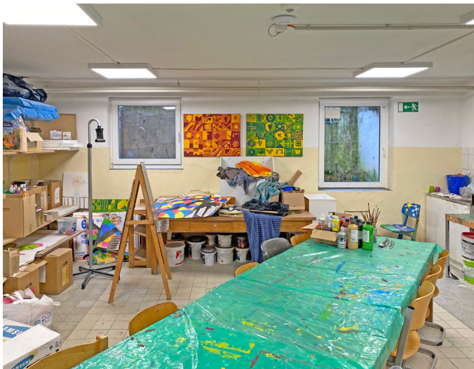
Werkraum im Keller, ehemaliger Dusch- und Umkleidebereich der Sporthalle. Wird intensiv – vor allem nachmittags – genutzt, ist jedoch für eine ganze Klassengröße zu klein.
