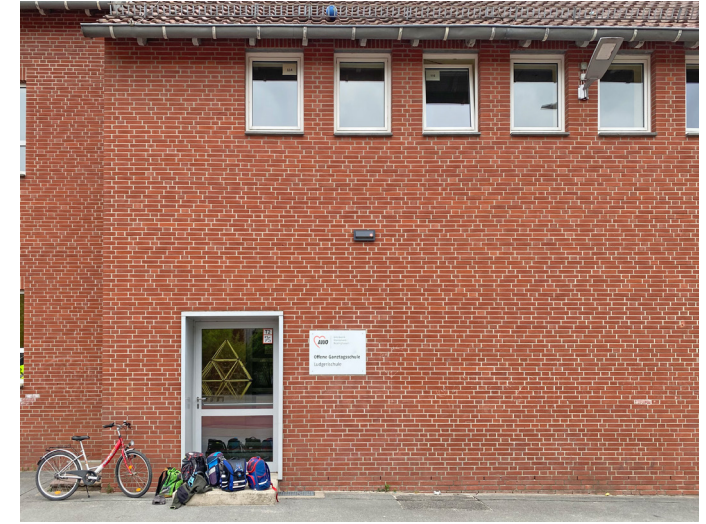
Eingang zum OGS-Bereich.
