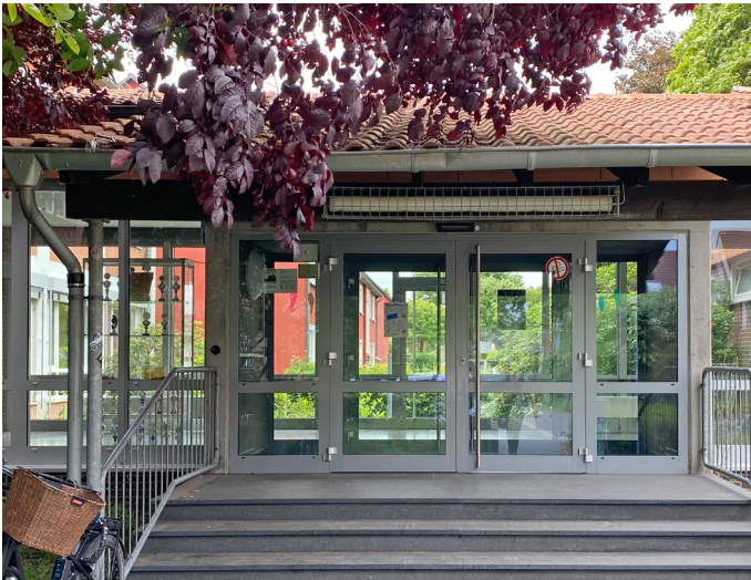
Zweiter Zugang zur Schule über den Anbautrakt.
