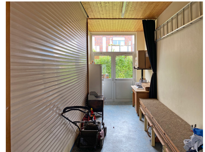
Bühnenbereich der Aula; wird aktuell auch zur Lagerung von Gartengeräten genutzt.
