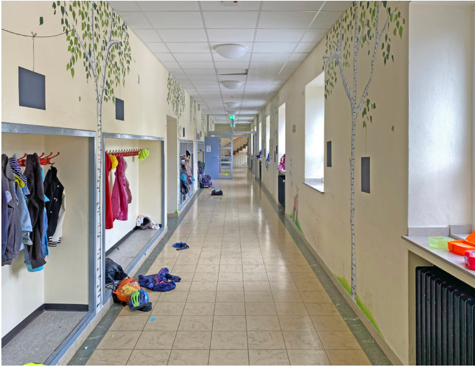
Flursituation mit Garderobennischen; Akustikdecke ist bereits installiert.
