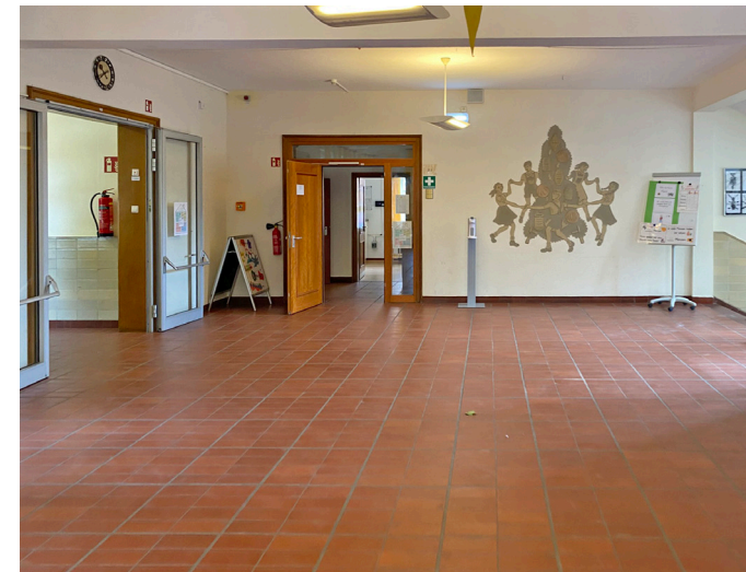
Die Aufenthaltsqualität ließe sich durch eine bessere Akustik, optimierte Beleuchtung und zusätzliche Möblierungselemente steigern
