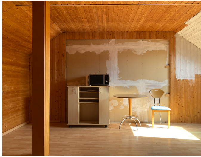
Ausgebautes, aber kaum genutztes Dachgeschoss der ehemaligen Hausmeisterwohnung über dem Trakt der Pausentoiletten.
