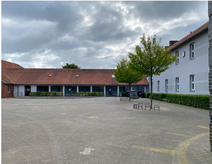
Hofeingang der Schule mit dem für die Bauzeit typischen Trakt der Pausentoiletten.
