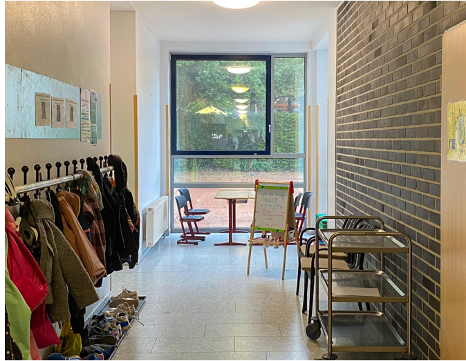
Flurzonen werden teilweise als Arbeitsbereiche genutzt; Garderoben sind überlastet.
