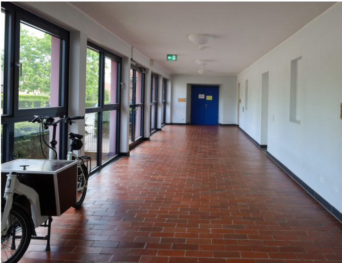
Hofeingang im Trakt der Pausentoiletten. Diese waren ursprünglich zum Hof hin offen und wurden eingehaust, sodass die Kinder die WCs wettergeschützt erreichen können.
