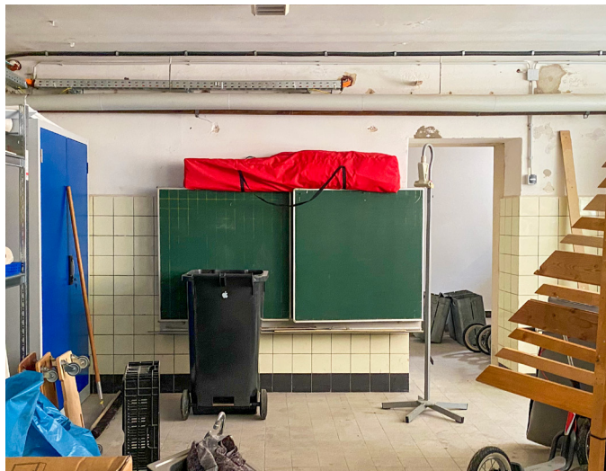
Ehemalige Lehrküche im Keller der Schule.
