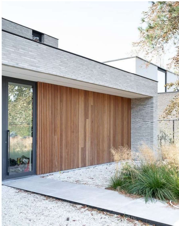
Vertikale Holzfassade mit offener Fuge
