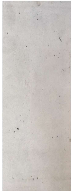
Oberfläche Sichtbeton Fertigteile
