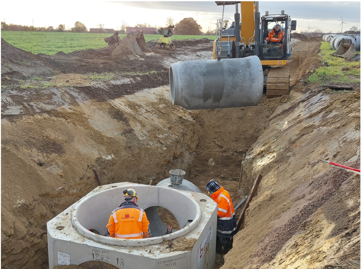
Verlegung Regenwasserkanal im Gewerbegebiete Letter Bülden
