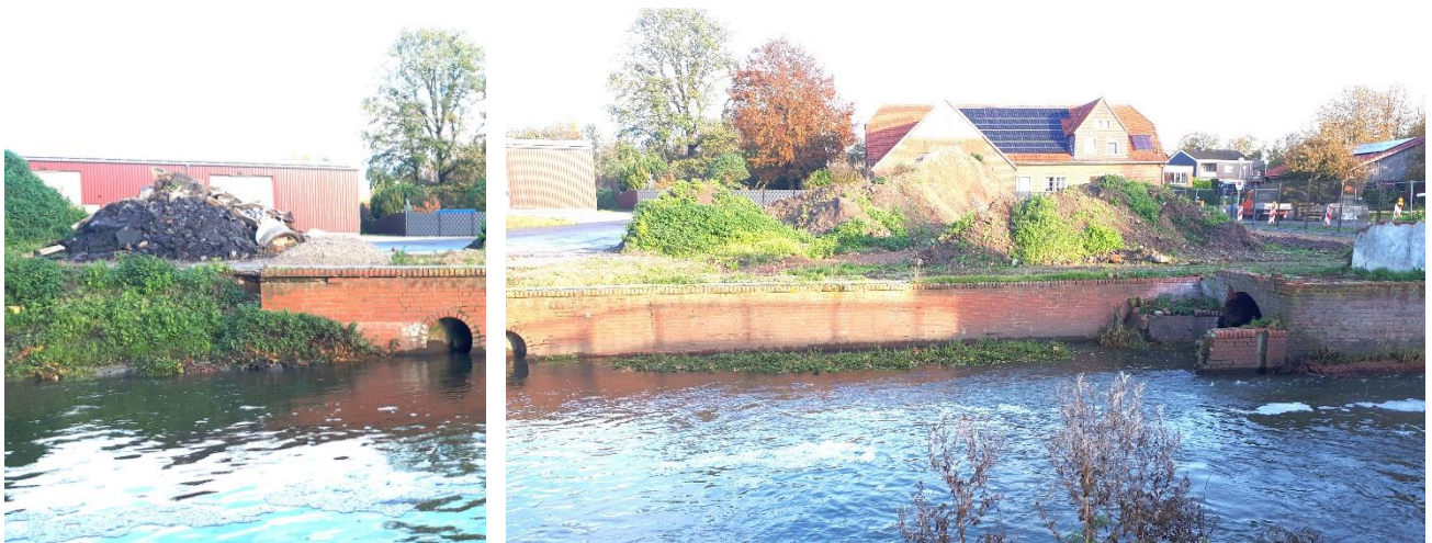
Fotos: nördliches Ufer im Bereich der Stauanlage
