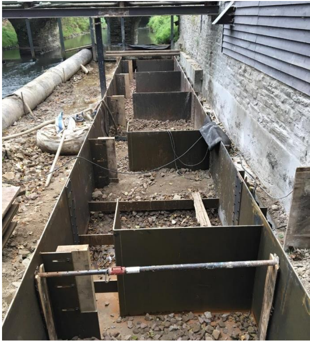
Fotos: Ausführungsbeispiel Stahlrog FAA, links im Bau, rechts in Betrieb (Quelle: Flick IG)
