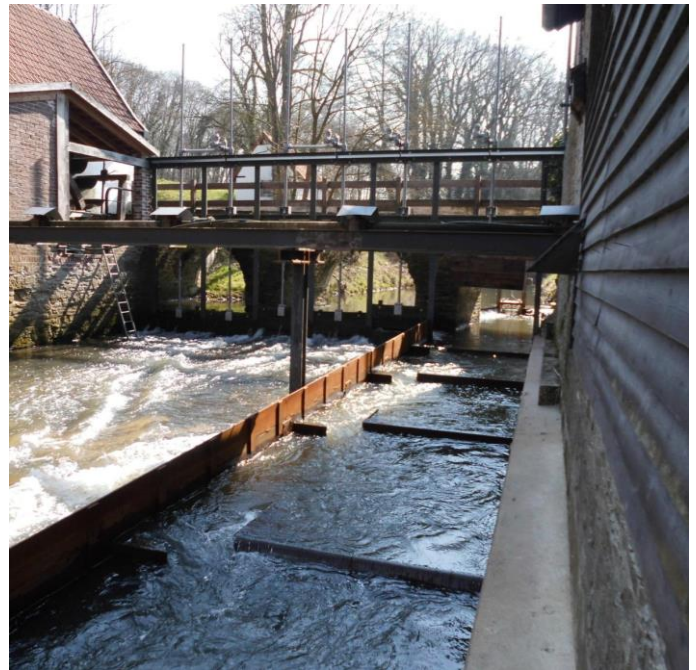
Fotos: Ausführungsbeispiel Stahlrog FAA, links im Bau, rechts in Betrieb (Quelle: Flick IG)
