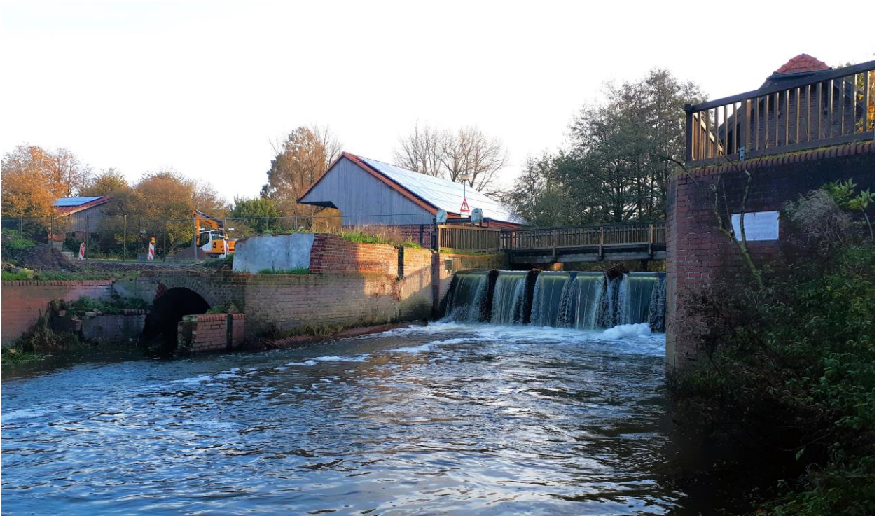
Foto: Ehemaliger Mühlenstandort
