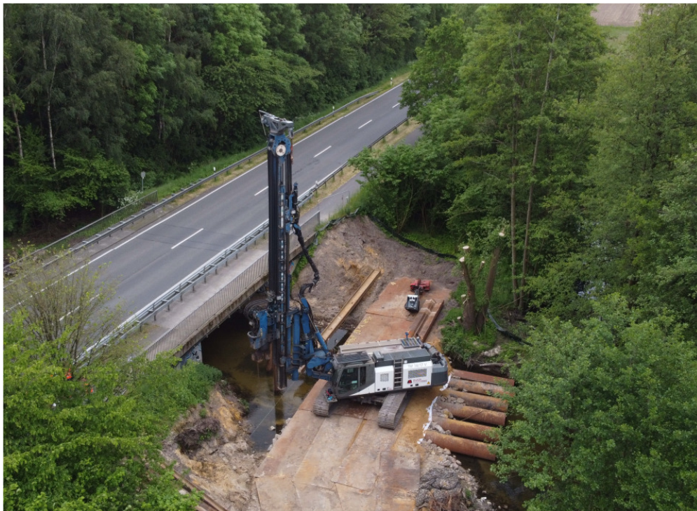
Errichtung einer Drosselwand zur Sicherung des erweiterten Retentionsraumes
