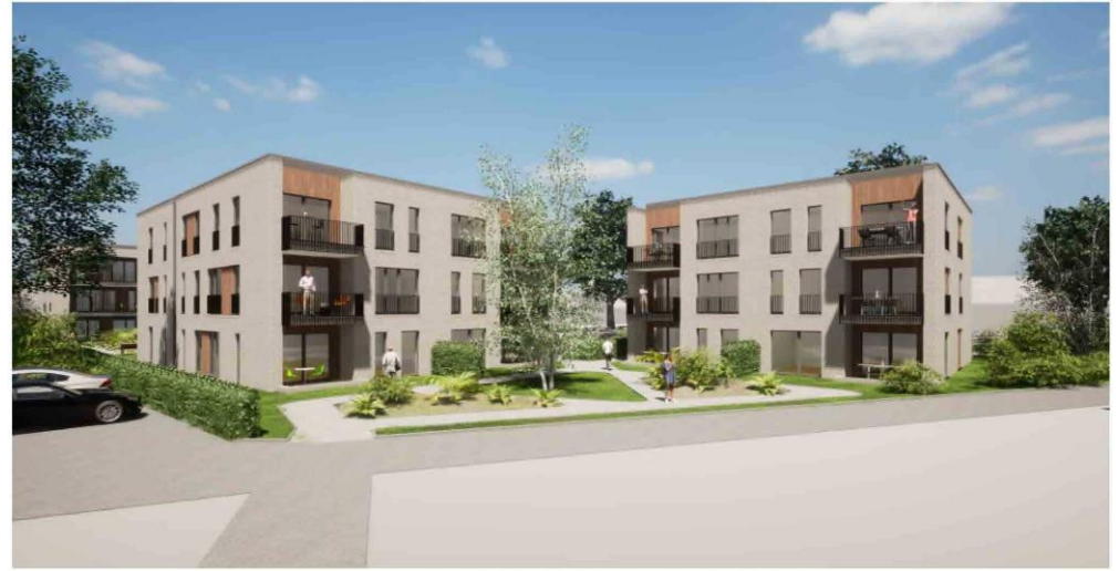
Garten Wohngemeinschaft, Gebäude C-D
