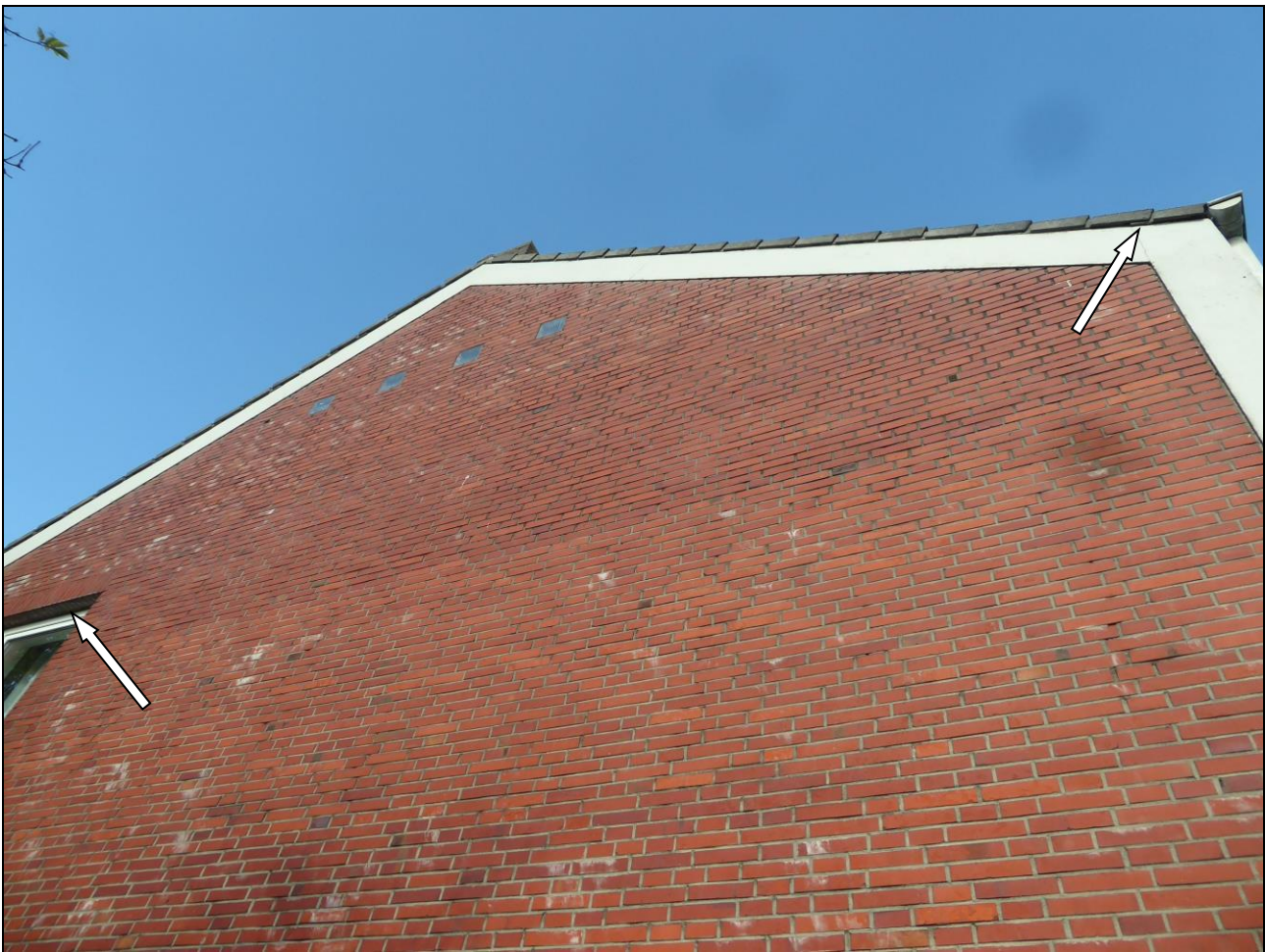
Abb. 5: Blick auf die Giebelseite eines der Abrisshäuser mit Kennzeichnung potenzieller Fledermausquartiere
