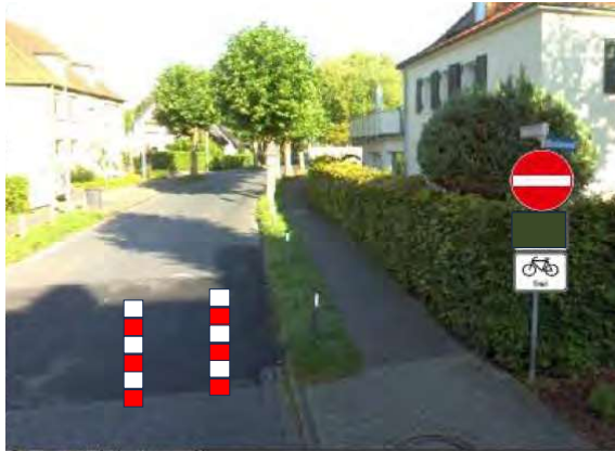
Ecke Basteiwall – Seminarstr. mit baulichen Maßnahmen (einseitig)
