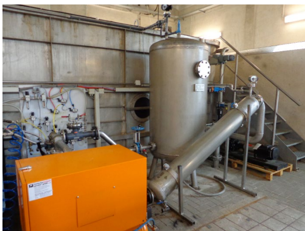
Abbildung 4: Flotation und Belebungsbecken (Kaskade 2/ N2)
