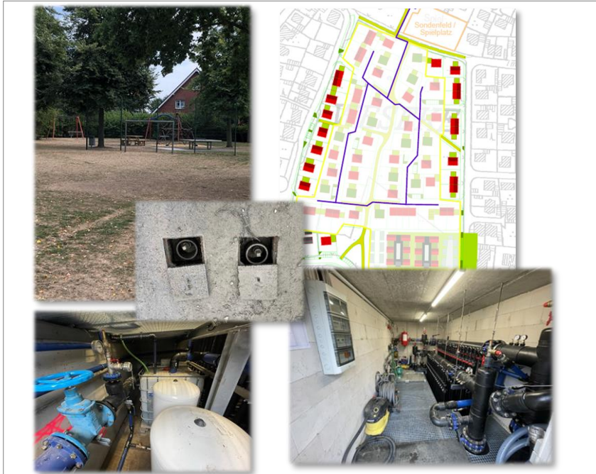
In Betrieb: Borken-Weseke
