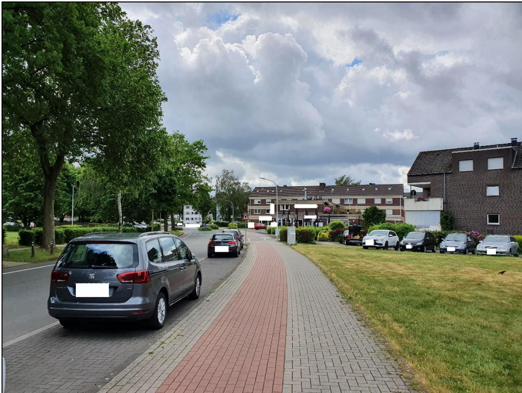
Abbildung 3: Blick auf Kalksbecker Weg 44, 46 und 48 sowie Birkenweg 2, Blick Südosten
