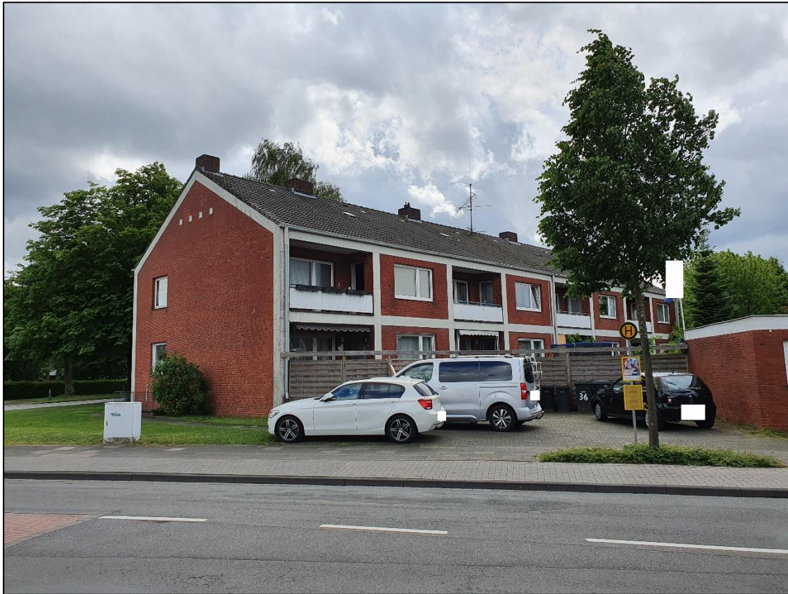
Abbildung 6: Wohnhaus Kalksbecker Weg 38 (Plangebiet), Blick vom Druffels Weg
