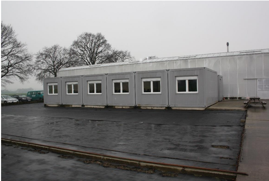
Abbildung 2.4: Aufenthaltsräume und sanitäre Anlagen in Container-Bauweise sowie davor gelegene Ansaatbeete mit schwarzer Abdeckfolie
