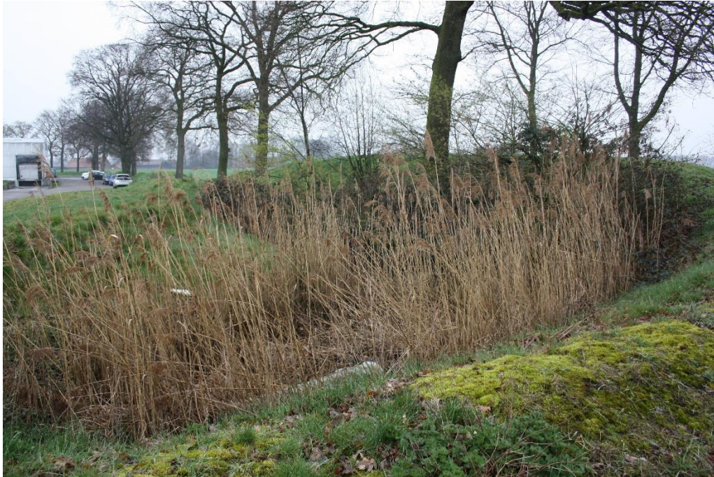
Abbildung 2.7: Regenrückhaltebecken im südwestlichen Teil des Bebauungsplangebiets sowie im Hintergrund die Mitarbeiterparkplätze
