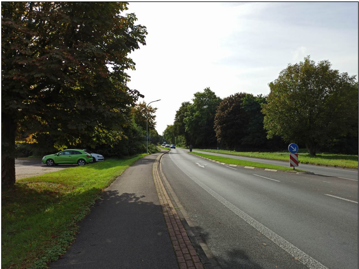
Abbildung 3: Derzeitige straßenräumliche Situation des Konrad-Adenauer-Rings (B 474), Blickrichtung Süden
