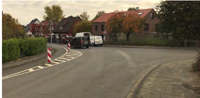
Abbildung 5-11: fehlende Sicherung des querenden Fuß- und Radverkehrs am Knotenpunkt Hengtering / Seminarstraße
