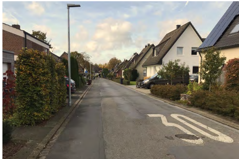
Abbildung 5-13: Fehlende Nebenanlagen am Hengtekamp
