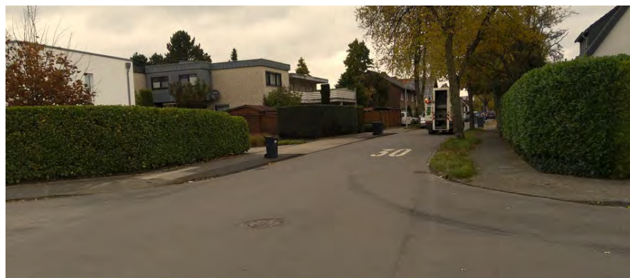
Abbildung 5-19: Differenzierte Bordhöhen fehlen mancherorts
