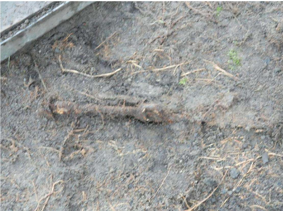
Ausgeprägter Wurzelhorizont in Bettung der Pflasterung, keine tiefergehende Durchwurzelung da der Unterboden aus verdichteter Schotterlage besteht
