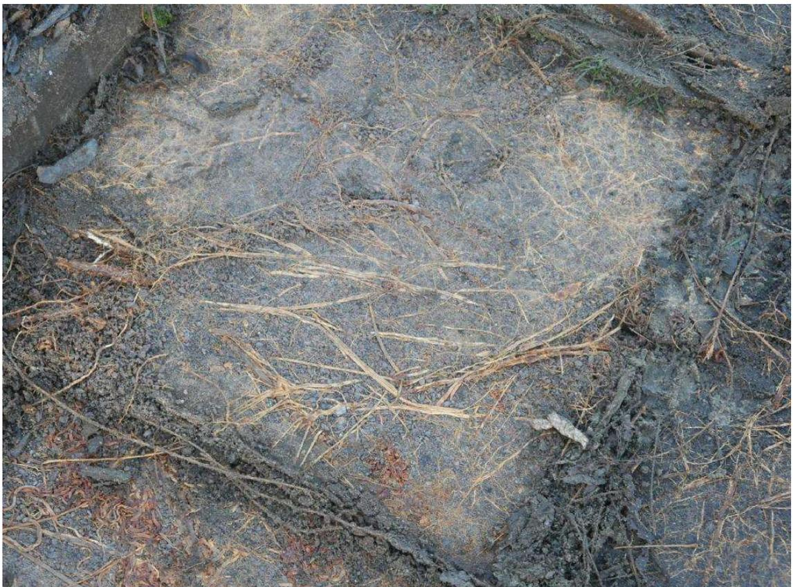
In Teilbereichen keine verdichtete Schotterlage, sondern Sand. Daher Bettung der Pflasterung weniger intensiv durchwurzelt und Wurzelhorizont tieferliegend
