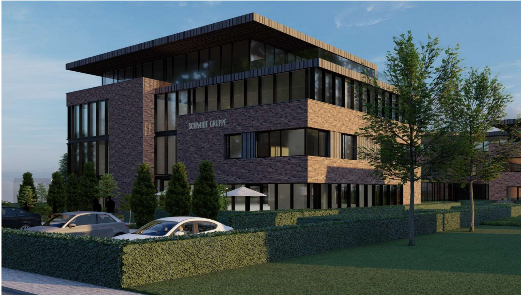
Ansicht Daruper Straße
