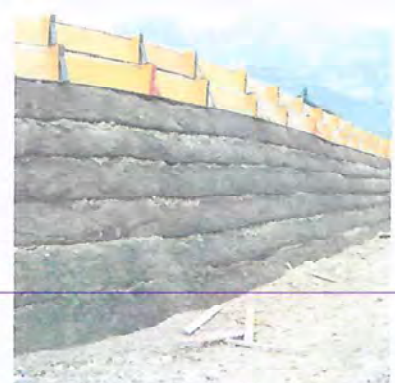
Polyslope T wird ohne permanente Schalungselemente errichtet; die "unschönen" Verformungen sind nach dem Aufgehen des Bewuchses nicht mehr sichtbar!
