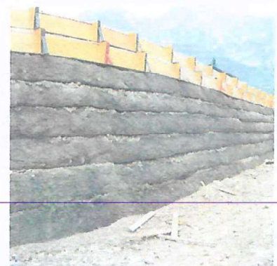
Polyslope T wird ohne permanente Schalungselement errichtet; die "unschönen" Verformungen sind nach dem Aufgehen des Bewuchses nicht mehr sichtbar!
