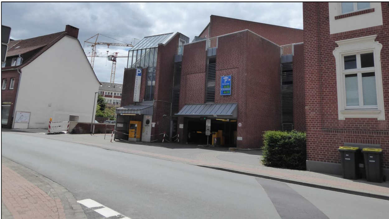
Abbildung 3: Münsterstraße Höhe Parkhaus „Am Krankenhaus“ in Fahrtrichtung Südosten
